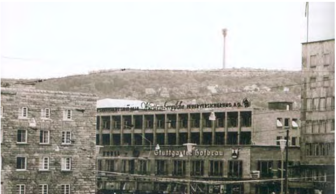
Aussicht auf den Turm während der Bauphase vom Stuttgarter Stadtzentrum aus.
