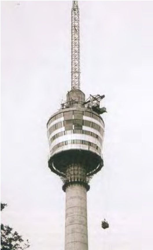
Der Turmkorb im Bau
